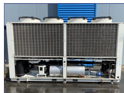
Grupo refrigeración agua
